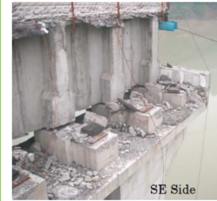
Views for the fallen sections of the Bridge 桥梁受损和倒塌的部分
